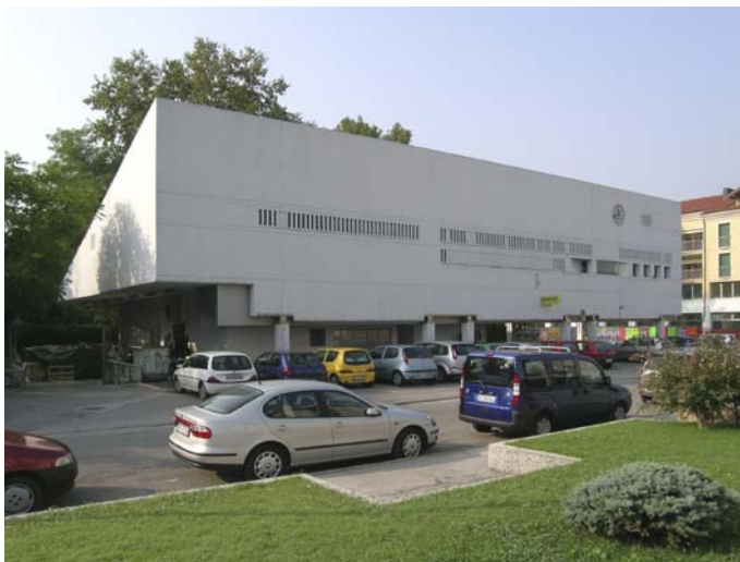
Geschäftshaus Casa Gialla, 1967–69 und Postamt, 1983–85 Adresse: Mira, Via Antonio Gramsci 13 und Via Vittorio Alfieri 5 Architekten: Cappai Mainardis
