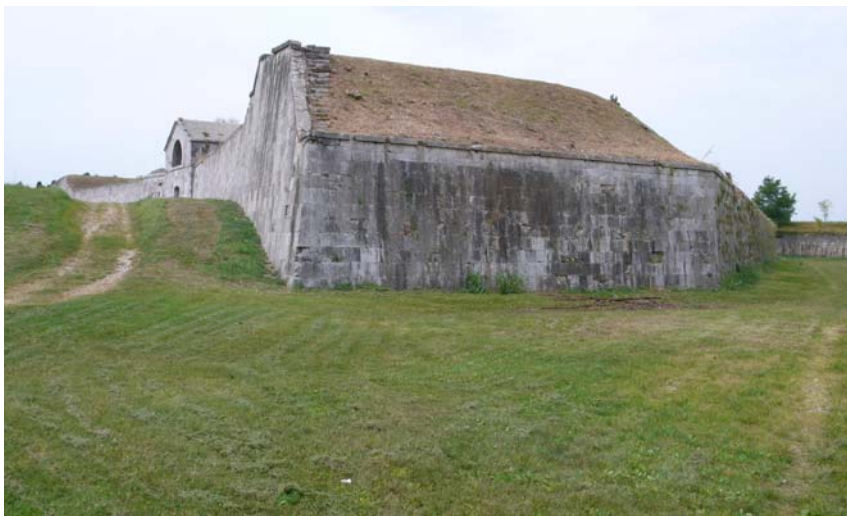
4 Befestigungsanlagen Adresse: Palmanova, Via Risorgimento
