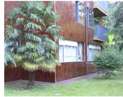
13 Wohnhaus, 1968–70 Adresse: Udine, Piazzale Cadorna Architekt: Gianni Avon
