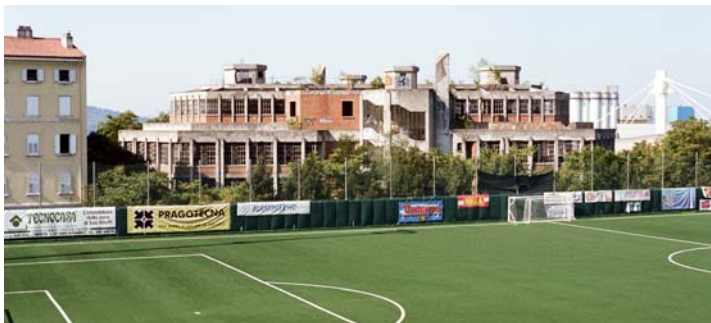
19 Mensa, 1956-58 Adresse: Triest, Via Carli 12 Architekt: Marcello D'Olivio
