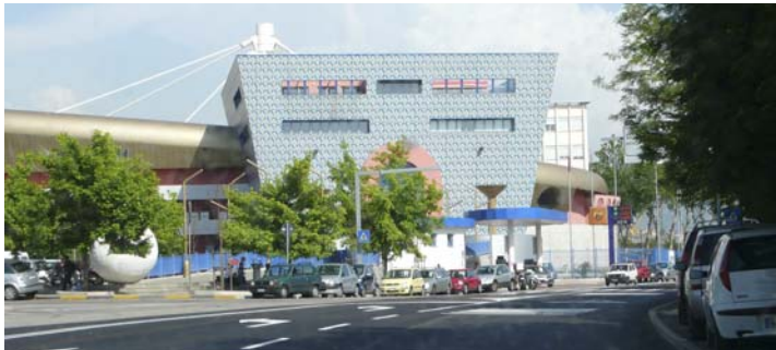
18 Hallenbad, 2004 Adresse: Triest, Passeggio di Sant'Andrea 8 Architekt: Alessandro Mendini
