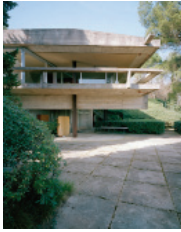
29 VITTORIANO VIGANÒ: Sommerhaus, Portese, 1957–60
