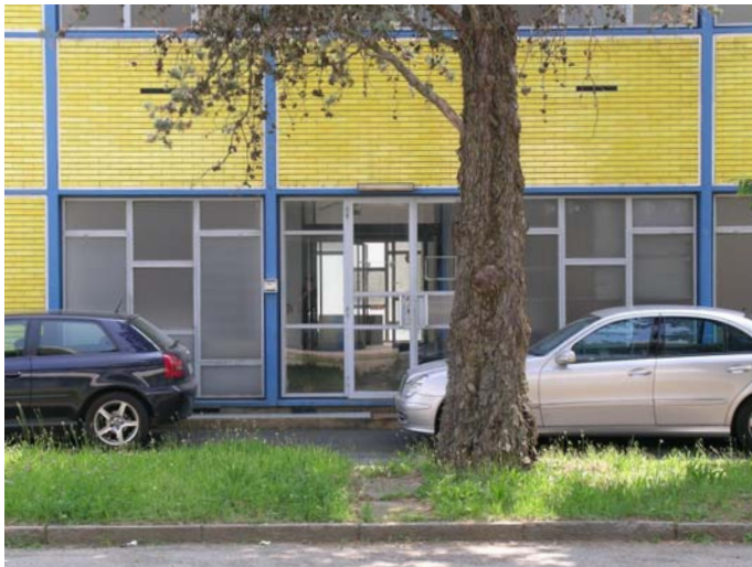
40 Krankenstation, 1956–58 Adresse: Ivrea, San Bernardo, Strada Torino 603 Architekt: Eduardo Vittoria
