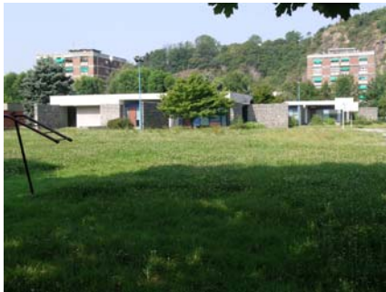
30 Volksschule, 1955–64 Adresse: Ivrea, Viale della Liberazione 5 Architekt: Ludovico Quaroni
