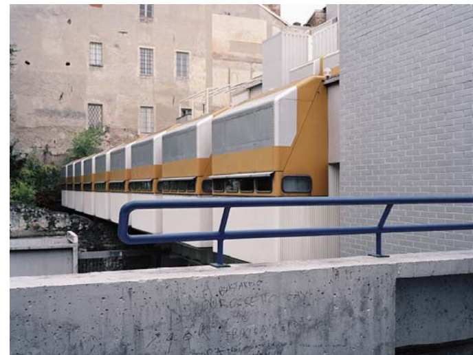
13 Hotel, 1967–75 Adresse: Ivrea, Corso Botta 30 Architekten: Iginio Cappai, Pietro Mainardis
