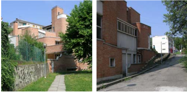
34 Evangelische Kirche, 1963–67 Adresse: Ivrea, Strada Torino 217 Architekt: Giovanni Klaus Koenig
