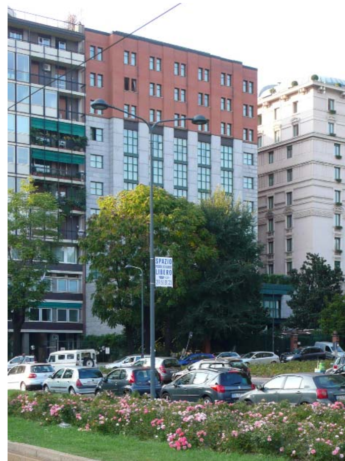
33 Hotel Duca di Milano, 1988-91 Adresse: Piazza della Repubblica 13 Architekt: Aldo Rossi
