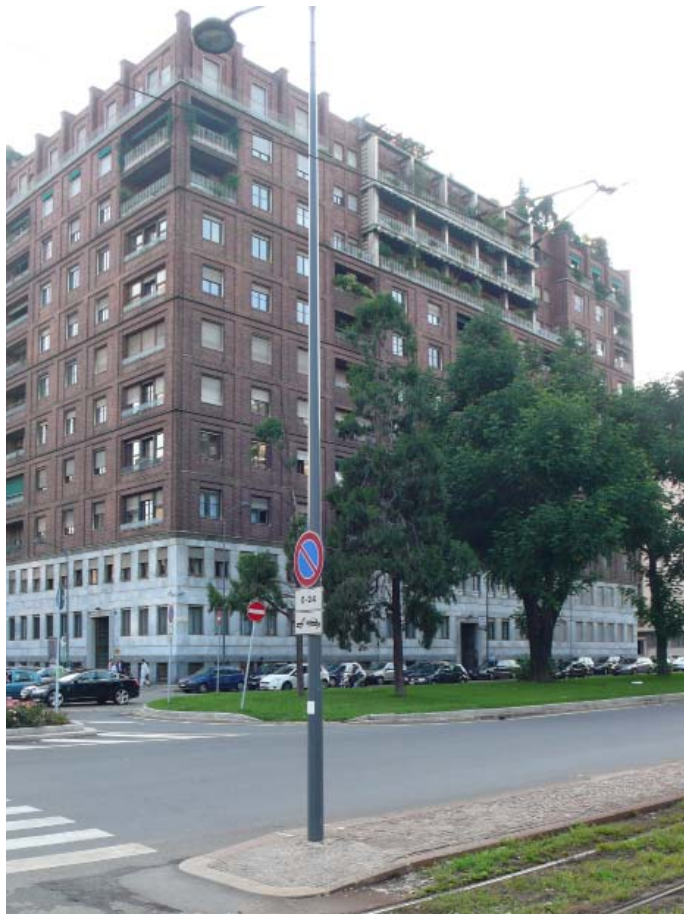
31 Wohnblöcke, 1935-36 Adresse: Piazza della Repubblica 5-9, Via Marcora 10-12 Architekt: Giovanni Muzio
