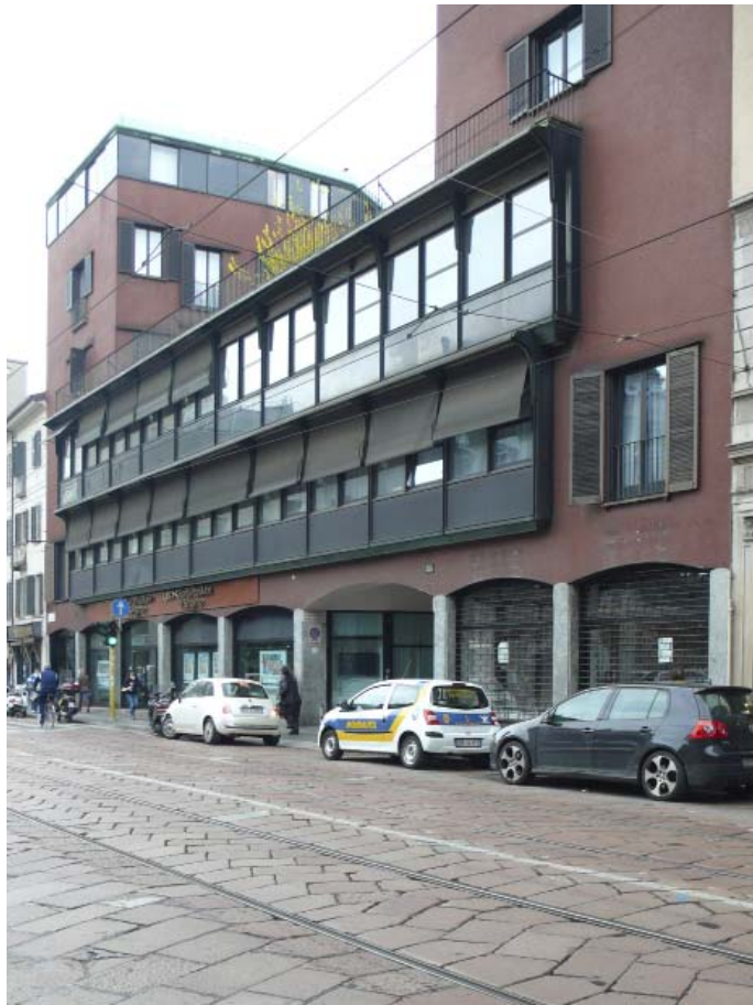
7 Wohn- und Geschäftshaus, 1957-64 Adresse: Corso Italia 22-24 Architekt: Luigi Caccia Dominioni
