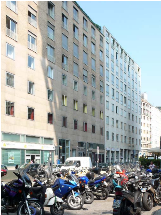
4 Wohn- und Bürohäuser bei der Torre Velasca, 1947-56 Adressen: Piazza Velasca 4, Via Paolo da Cannobbio 33, Via Albricci 10 Architekten: Asnago & Vender
