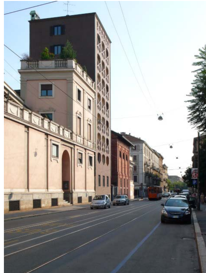
37 Kloster, Mailand, 1960-63 Adresse: Via Carlo Farini 10 Architekt: Luigi Caccia Dominioni
