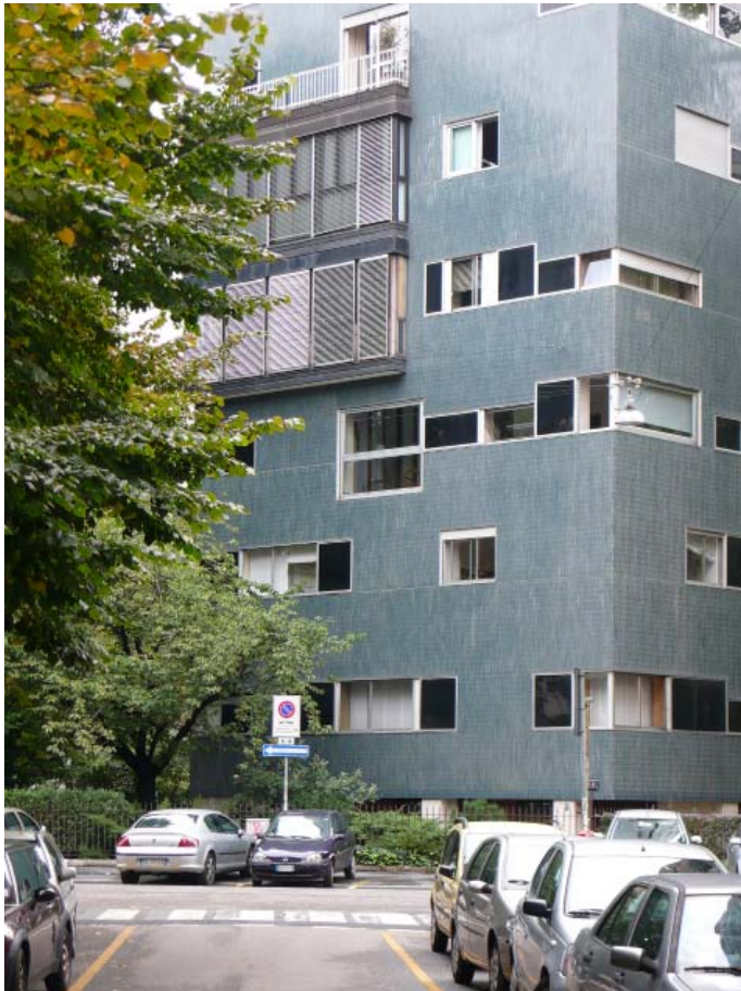
41 Wohnhaus, 1955-57 Adresse: Via Ippolito Nievo 28/1 Architekt: Luigi Caccia Dominioni
