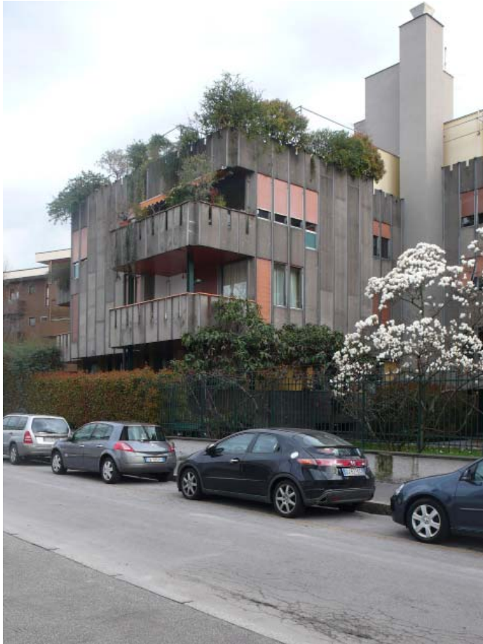
49 Wohnhaus, 1961-64 Adresse: Via Laveno 6 Architekt: Marco Zanuso
