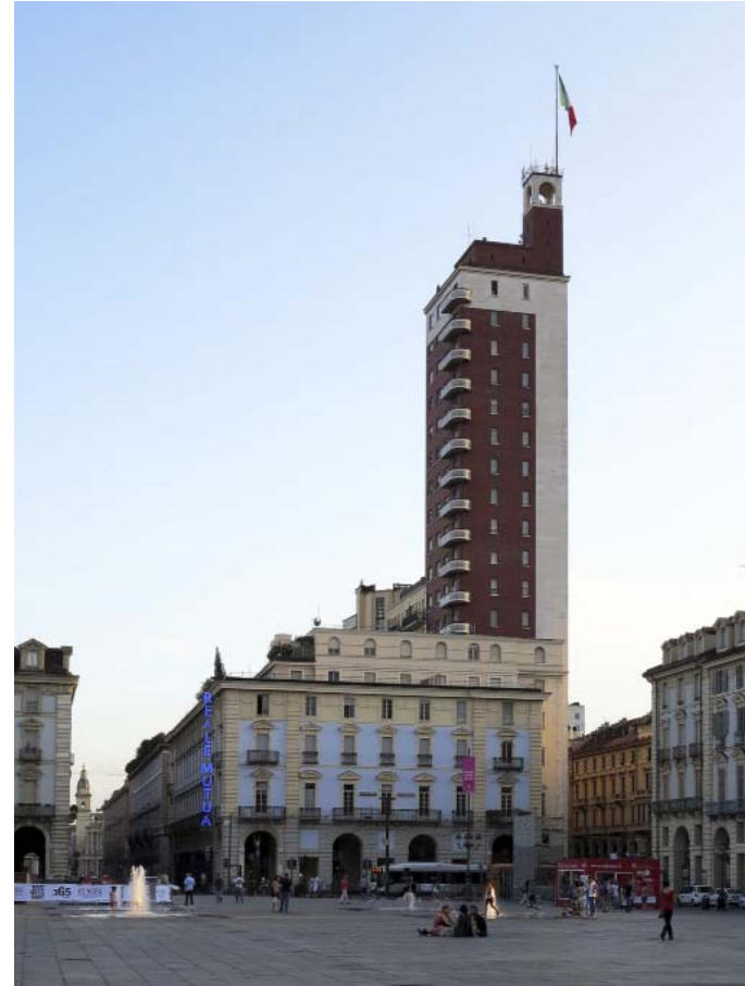
14 Torre Littoria, 1933–35 Adresse: Piazza Castello, Via Roma, Via Viotti 1 Architekten: Armando Melis de Villa, Giovanni Bernocco
