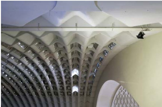
15 Palazzo della Moda, Palazzo delle Esposizioni, 1936–38 / 1947–50 Adresse: Corso Massimo d'Azeglio 15 Architekten: Ettore Sottsass sen., Carlo Biscaretti di Ruffia, Pier Luigi Nervi
