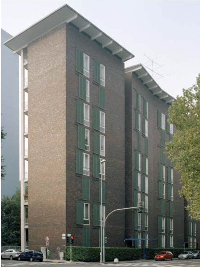
5 Wohnhaus Borsalino, 1948–52 Adresse: Alessandria, Corso Teresio Borsalino 15 Architekt: Ignazio Gardella
