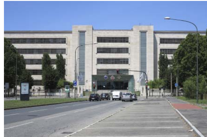
16 Casa del Fascio, 1938 Adresse: Corso Eusebio Giambone 2 Architekten: Mario Passanti, Paolo Perona
